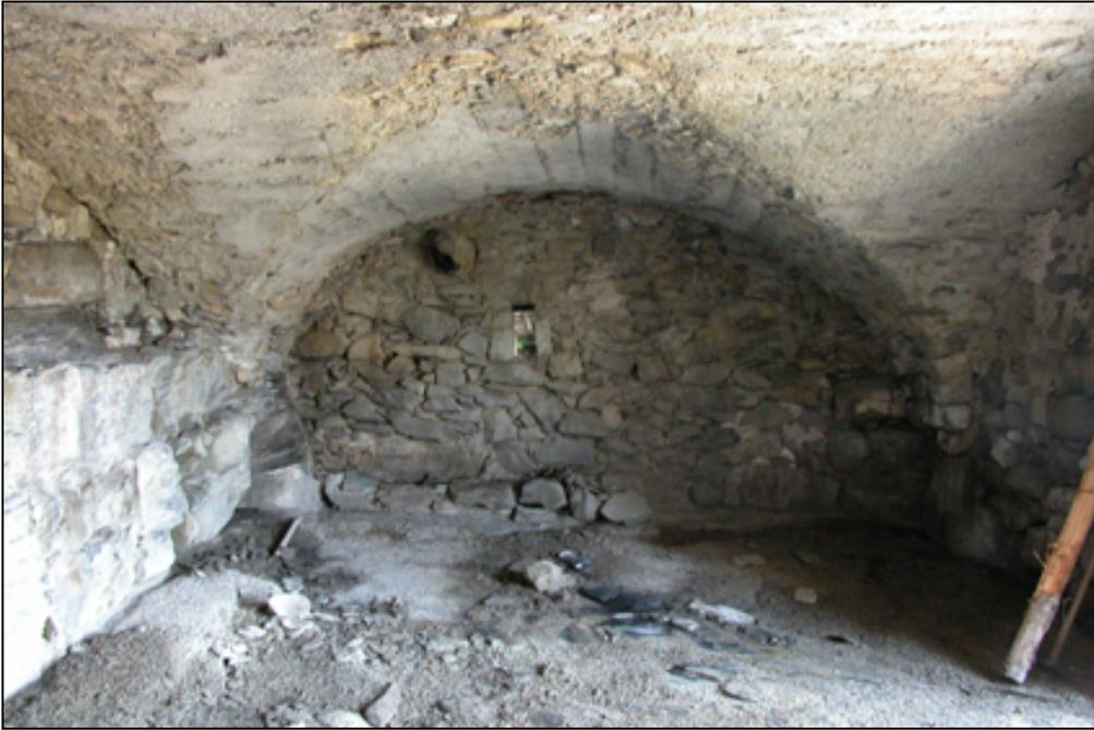
Etable dans l'étage de soubassement couverte d'une voûte d'arêtes (mur est).
