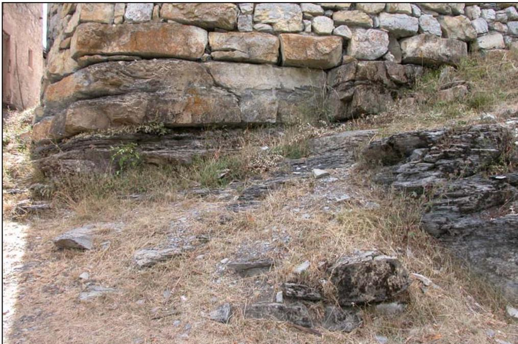
Edifice agricole en avant-corps. Les premières assises en moellons semblent se confondre avec le rocher de calcaire argileux affleurant.
