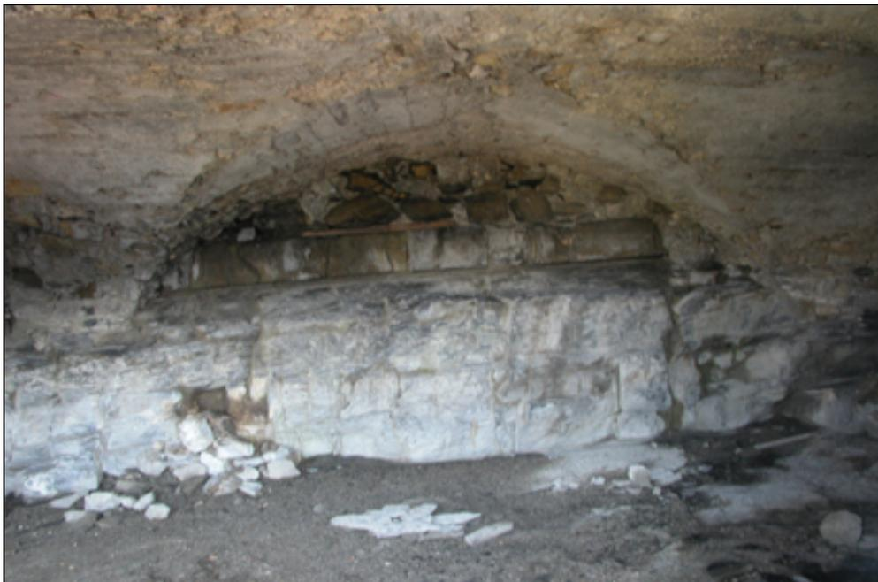
Etable dans l'étage de soubassement (face nord). Le rocher est affleurant et remplace un mur.
