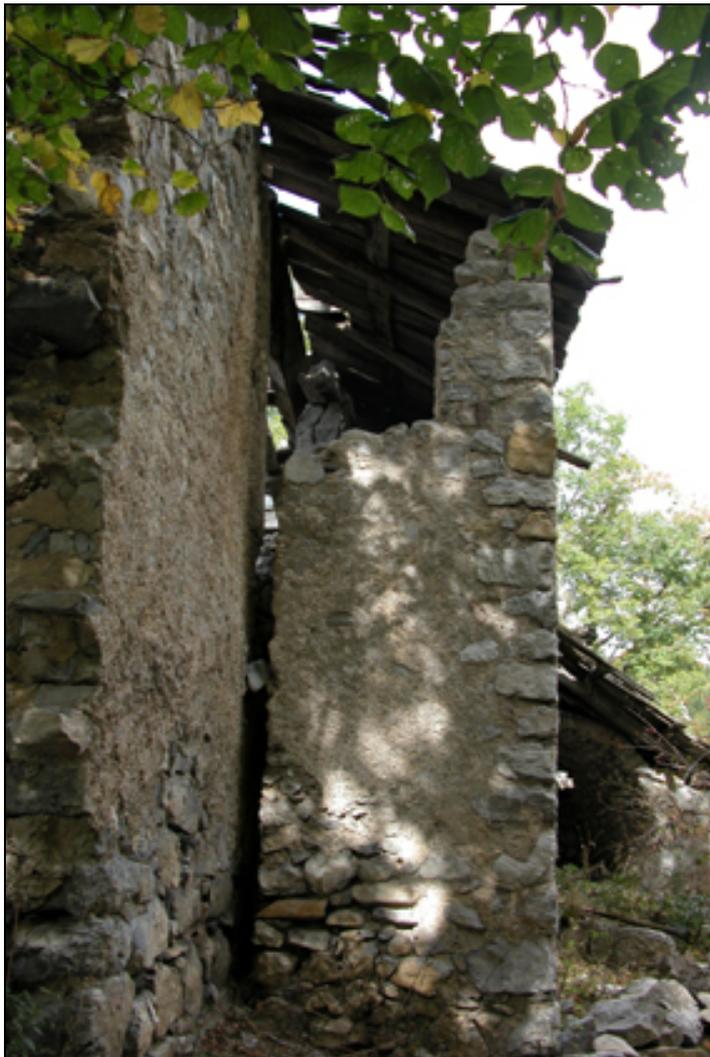
Ci-contre : corps de bâtiment abritant la porte d'entrée du logis, le vestibule et l'escalier intérieur. Construit bien après la maison ; on constate la désolidarisation des maçonneries.
