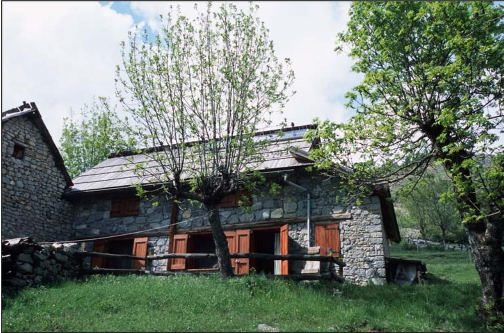
*Sousta* d'autrefois, désormais local pastoral professionnel. La façade a été obturée et scandée de fenêtres. La toiture de bardeaux refaite sert de support à des panneaux solaires.
