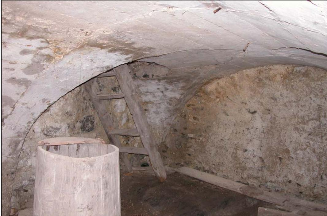
Cave en sous-sol, accessible de la cuisine par une échelle. Deux travées de voûtes d'arêtes.
