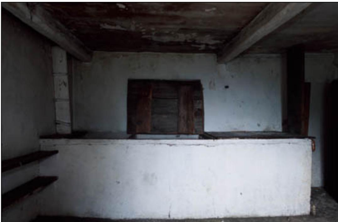
Chambre au-dessus de la cuisine : grenier (coffre maçonné) appuyé contre le mur nord.
