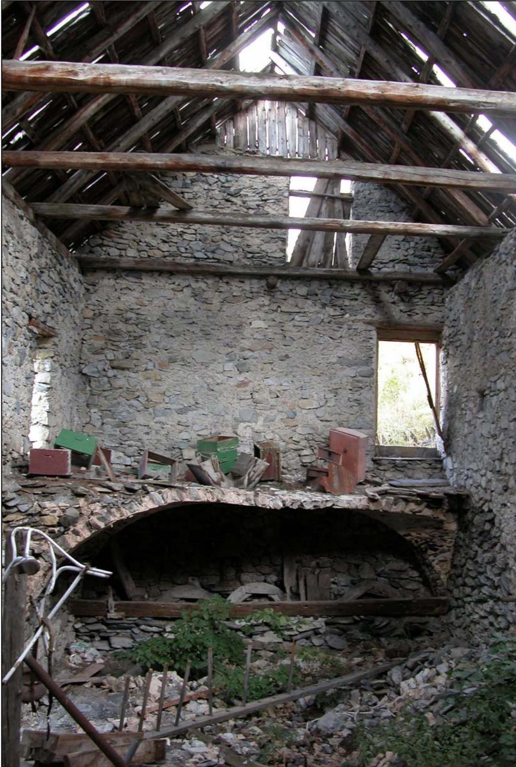
Intérieur de l'écurie : mur ouest. On y aperçoit les vestiges du voûtement d'arêtes. La dernière travée de voûte s'est écroulée durant l'automne 2003.
