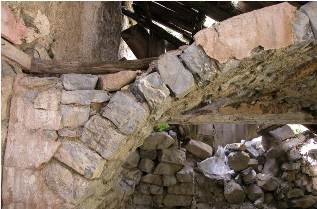
Détail de la voûte montée en tas-de-charge.
